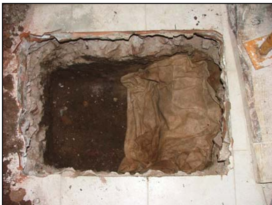
5 : Mur U.E. 104 tapat amb geotèxtil
