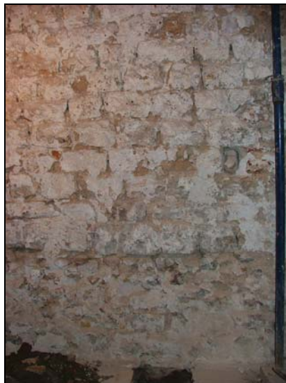
6: Mur de l'edifici
